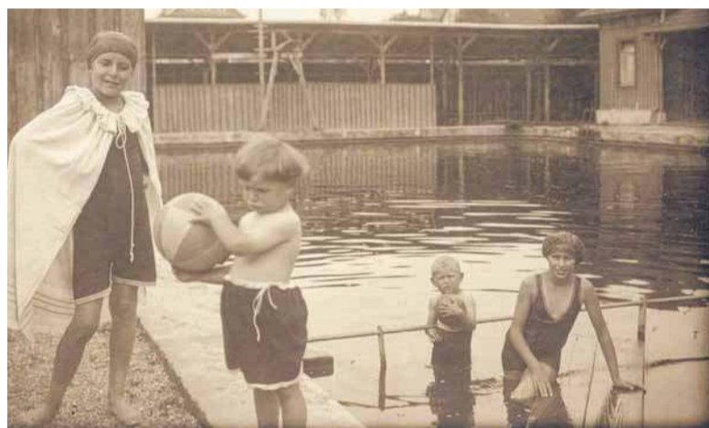
Inneres der Badeanstalt im Jahr 1927. Das Bassin hatte die Maße von 19 mal 14 Meter. Vorn das Kinderbassin, 55 bis 75 Zentimeter tief, hinten das Schwimmbassin, 95 bis 205 Zentimeter tief mit Katzenleiter-Sprungbrett.
