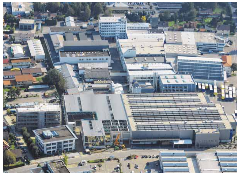
Waldner investiert derzeit auch in den Hauptsitz in Wangen. Das Luftbild zeigt den Stand der Bauarbeiten. FOTO: WALDNER
