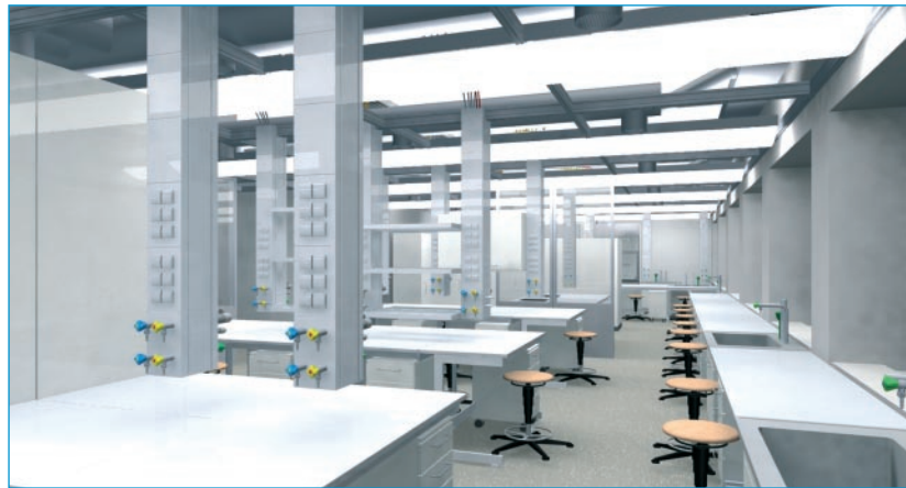
Beispiel für eine Raumversorgung über Mediendecke ■
