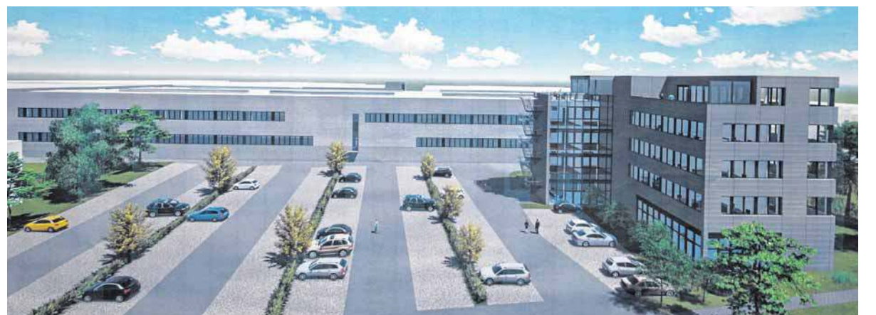
So soll das neue Waldner-Hauptquartier bis Mitte 2016 aussehen: rechts das fünfstöckige Bürogebäude, hinten die beiden aneinander gebauten, neuen Produktionshallen.
